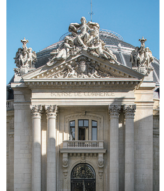
L'architecte Henri Blondel transforma l'ancienne halle aux blés en Bourse de Commerce pour l'Exposition universelle de 1889.
