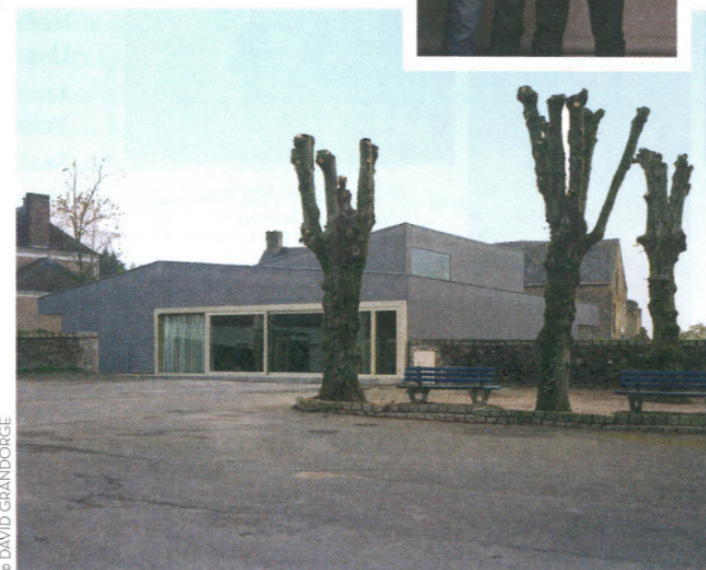
Hangar domestique et salle de loisirs à Pezé-le-Robert (Sarthe).
